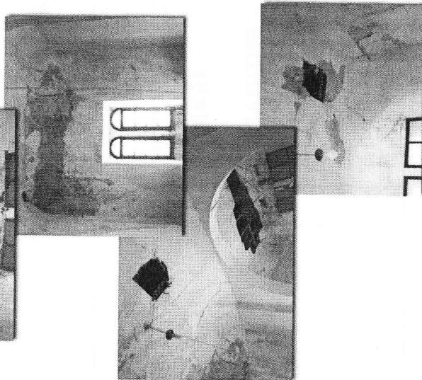
El deterioro en las fachadas está muy avanzado, especialmente en el lateral y la trasera, llegando incluso a producirse algunos desprendimientos.
