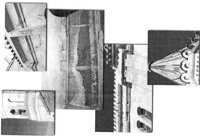
Pese a la restauración de la cúpula de hace 10 años, el estado del resto de las cubiertas requiere una intervención integral, debido al mal estado de las vigas de madera y el levantamiento del tejado. Se han provocado abundantes goteras en galerías y ábside. Esto ha dado lugar a cerrar los salones de la calle del Niño.
